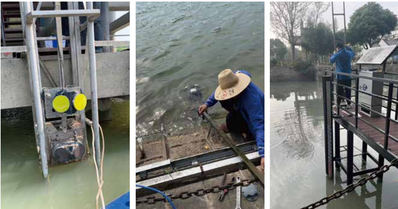
RIV H系列水平式声学多普勒流速剖面仪安装现场
